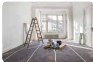
●施工現場・引渡し前の住宅
